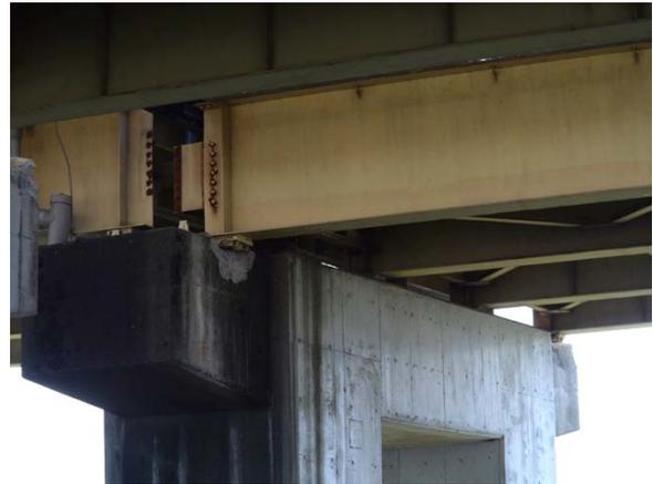
写真1 前震で落橋寸前の被害を受けた
